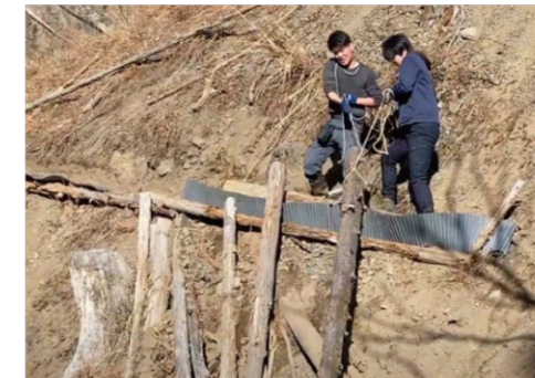
急斜面の崩れた道を補修 3月4日～5日
