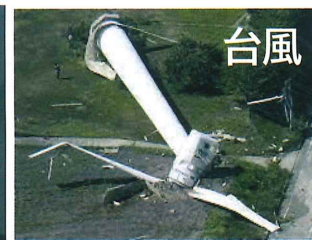
兵庫県淡路島 最大瞬間風速28.6m で倒壊。風速60m迄耐えられるはずが。
