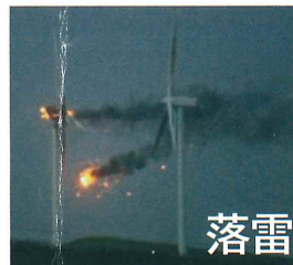
秋田県にかほ風力発電所
